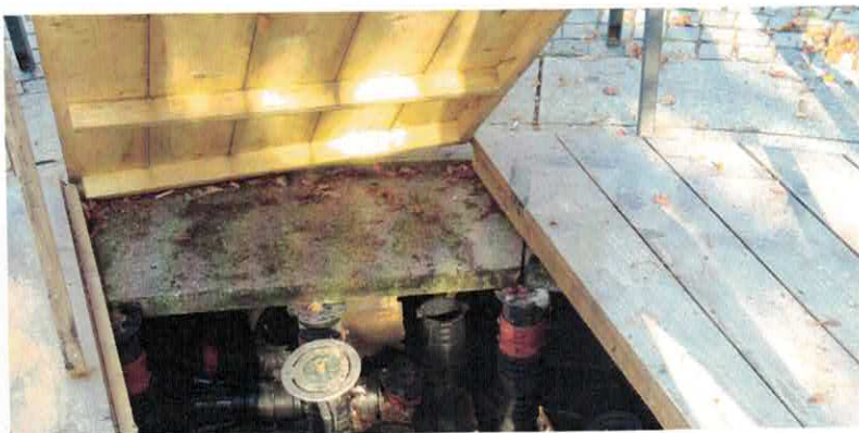
Fot. 03 Fontanna – zbliżenie na element zewnętrzny granitowy, który nie został zniszczony
