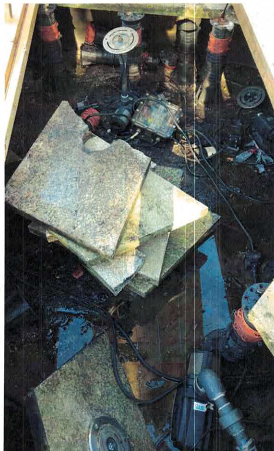
Fot. 02 Fontanna – widok ogólny zbliżenie (widoczne uszkodzone elementy granitowe płyty głównej oraz uszkodzona instalacja)
