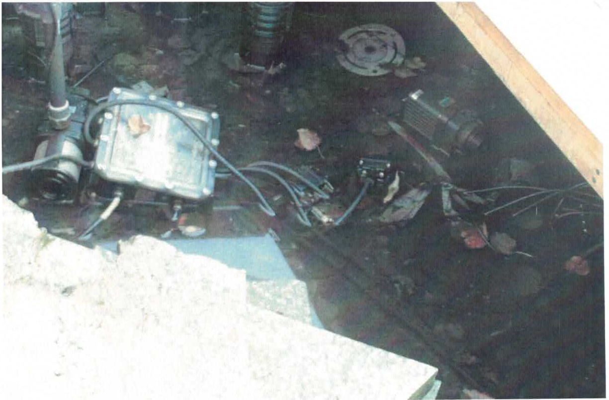
Fot. 06 Fontanna – uszkodzone zasilanie fontanny, na drugim planie zatopiona dysza
